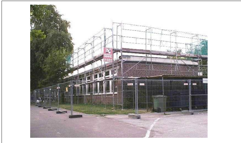
Abb.3: Umbauarbeiten im Jahre 2007
