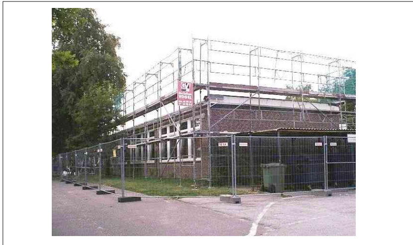
Abb.3: Umbauarbeiten im Jahre 2007
